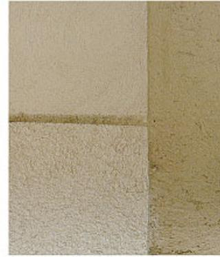
L'intonaco è formato da due strati successivi che si identificano in una prima fase in cui la parete viene "rattoppata" e portata a filo, ed una successiva in cui la stessa viene rifinita con la scelta dell'uso di colori.
